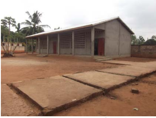
Progreso del colegio M. Matilde en Afagnan, Togo
